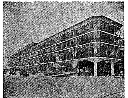
Fig. 48. Hus i Altadona. Maal 1:400. Fuldstændig Metalkonstruktion med Anvendelse af Standardelementer. Ydervæggen er dobbelt med Luftmellemrum, der tjener som Kanal for Luftpvarmning. Etageadskillelsen er ligeledes dobbelt, al Jernbeton udstøbt mellem Jerndragere, og den varme Luft fra Ydervæggene kan efter Behag ledes ind under Gulvene.
