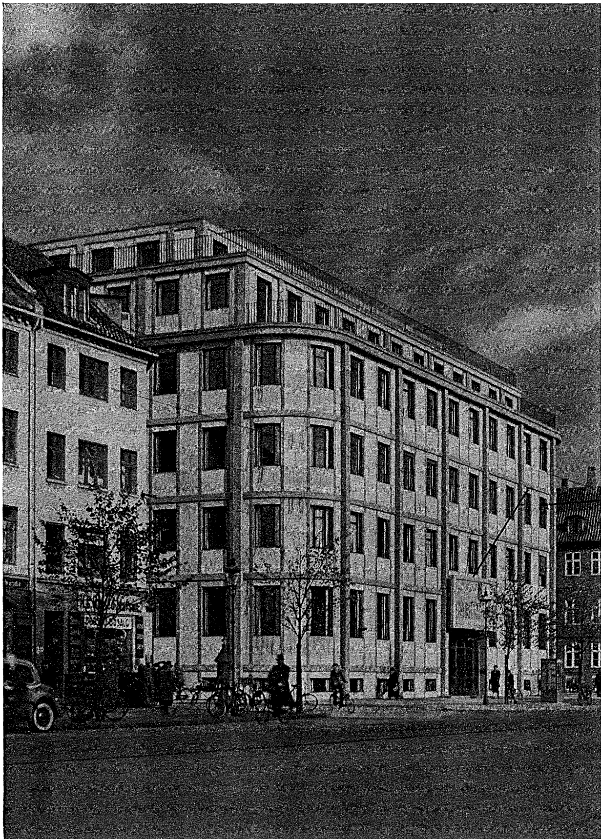
Fig. 43. Overformynderiet i København. Jernbetonskeletbygning. Indbyrdes Søjleafstand ca. 5,2 m. De isolerende ikke bærende Ydervægge er beklædt med 2 cm tykke Plader af grønlandsk Marmor.
